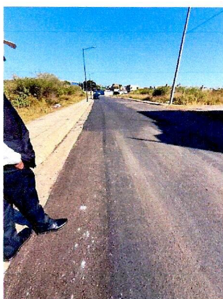
Fotografía 25. Supervisión Boulevard Bicentenario.
